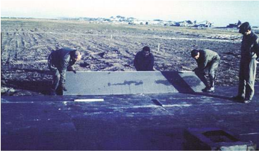
Colocación de planchas de aluminio en la BAM Malvinas - Gentileza: Com. VGM (R) Grünert
